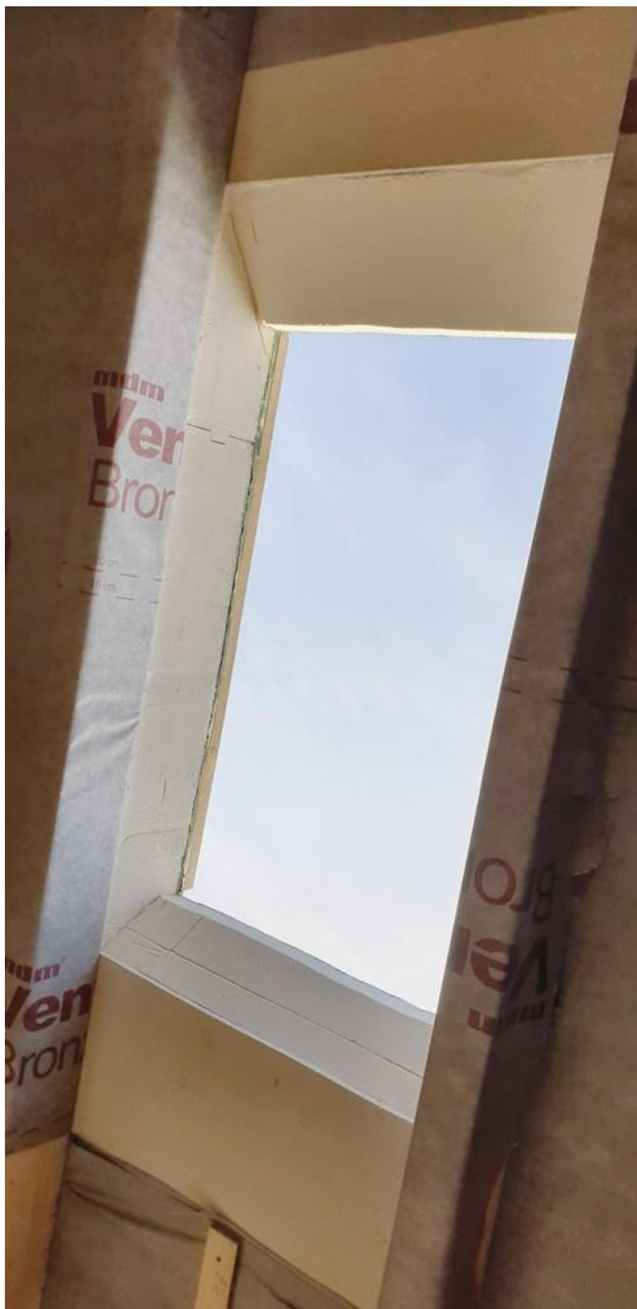
Otwór w polaci przygotowany do montażu okna dachowego i późniejszej szpalety – widok od wewnątrz na płyty izolacji nakrokwiowej Bauder PIR Plus 200mm
