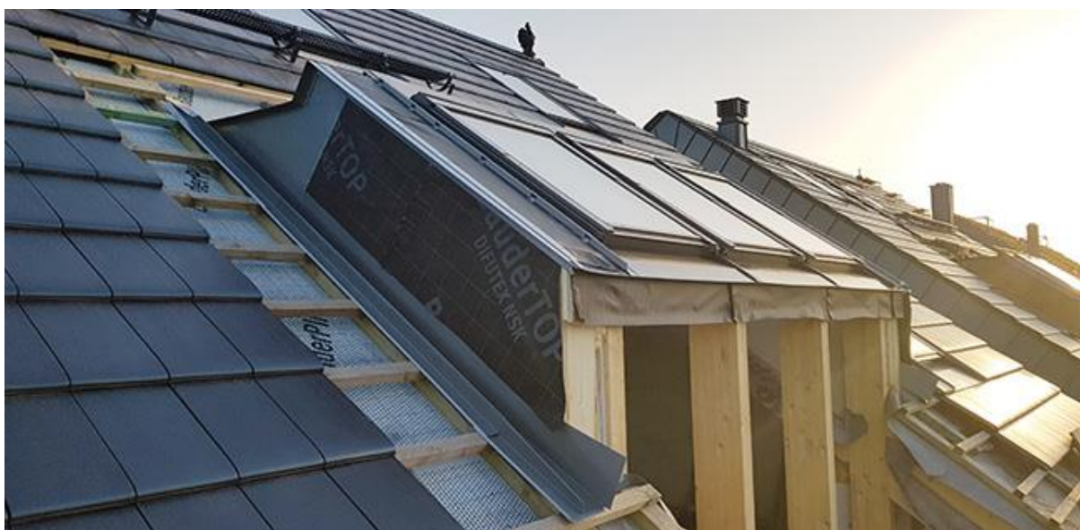
Wentylacja połaci nad górną częścią lukarny raz jeszcze – widoczna siatka i przeciw-spadek
