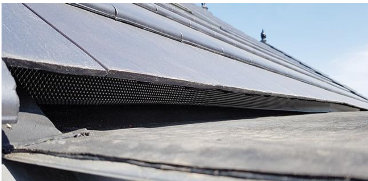
Wentylacja połaci nad górną częścią lukarny raz jeszcze – widoczna siatka i przeciw-spadek
