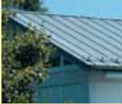
Izolacja pod dachem z metalu
