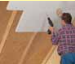
Izolacja pod krokwiami
