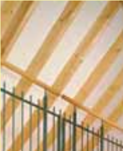
Izolacja na krokwiach
